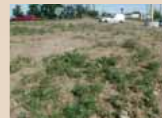
Sur les chantiers (comblés de remblais et de terre)
