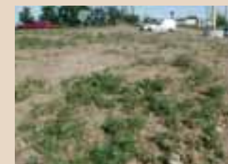
Sur les chantiers (comblés de remblais et de terre)
